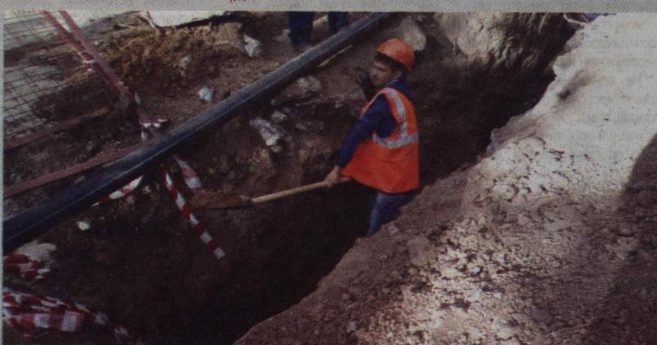
МУП «Водоканал» завершило работы по перекладке уличного водопровода диаметром 110 миллиметров на переулке С. Лазо. Трубопровод весьма почтенного возраста, ему около 30 лет. На нем периодически образовывались порывы, аварийные бригады Водоканала неоднократно приезжали на их ликвидацию, а жители жаловались на лужи на дороге и затопление дворов.
